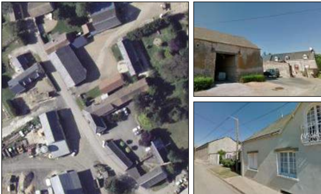
Photos : Google Street View Vues aériennes : Géoportail
